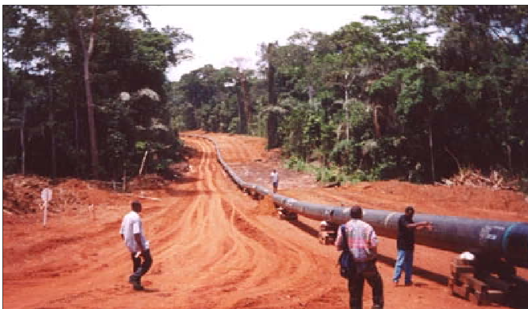
L'oléoduc en voie de construction
