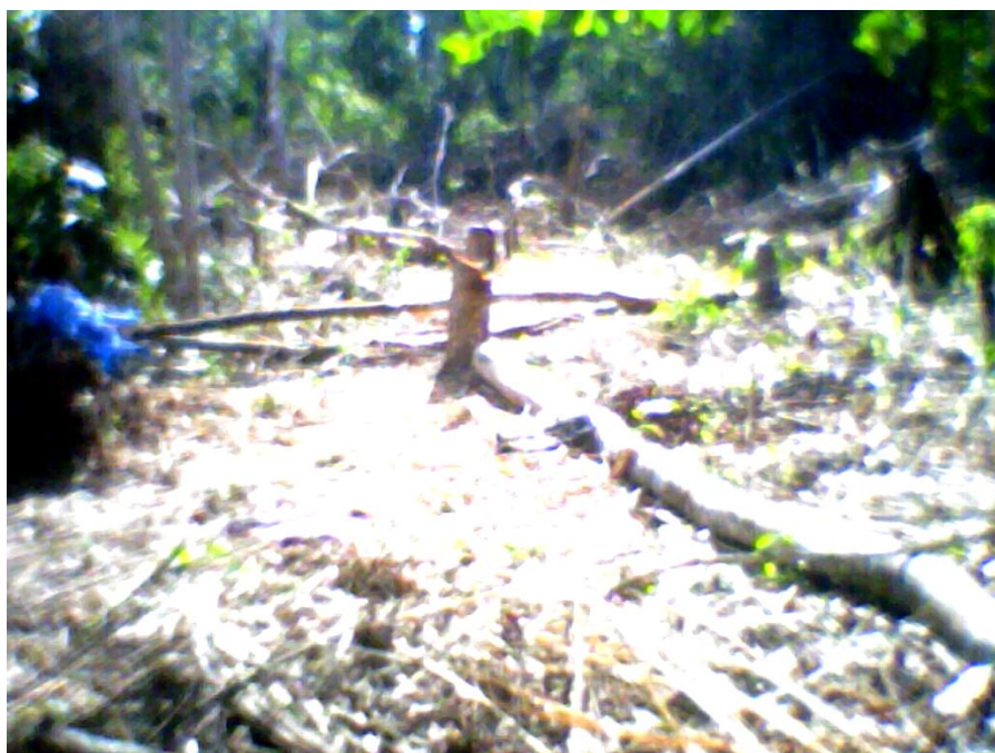
Figure 13: Le déboisement précédant l'installation d'un chantier
