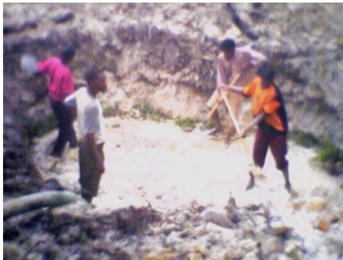
Figure 14: Puits ayant subi l'exhaure grâce à la motopompe
